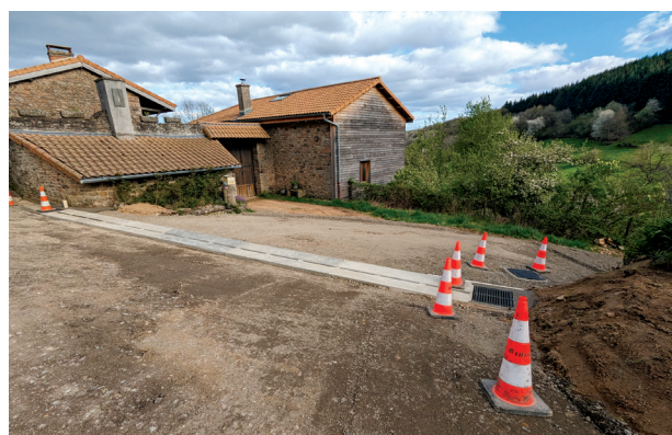
Caniveau réalisé aux Luquets
