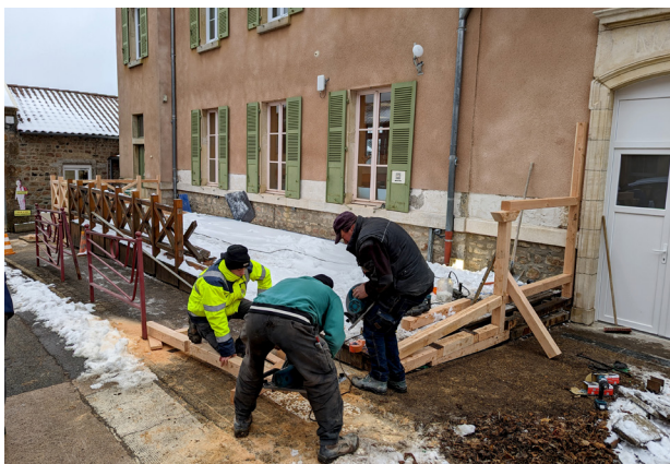
Réfection de la terrasse du restaurant par l'entreprise Sangouard
