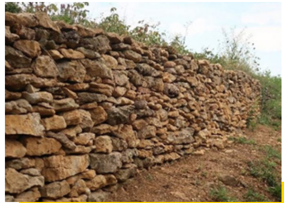
Restauration d'un mur en pierres sèches
